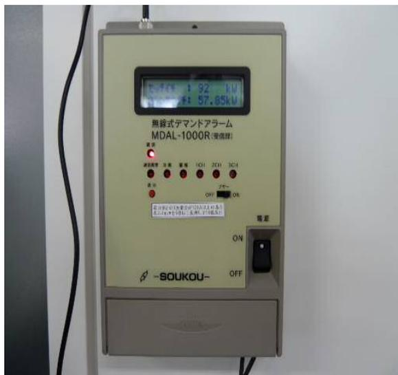
写真1 電力デマンド監視装置
