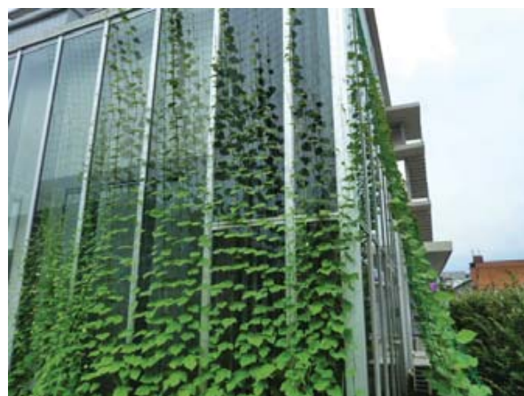
写真4 ヒョウタンによる壁面緑化
